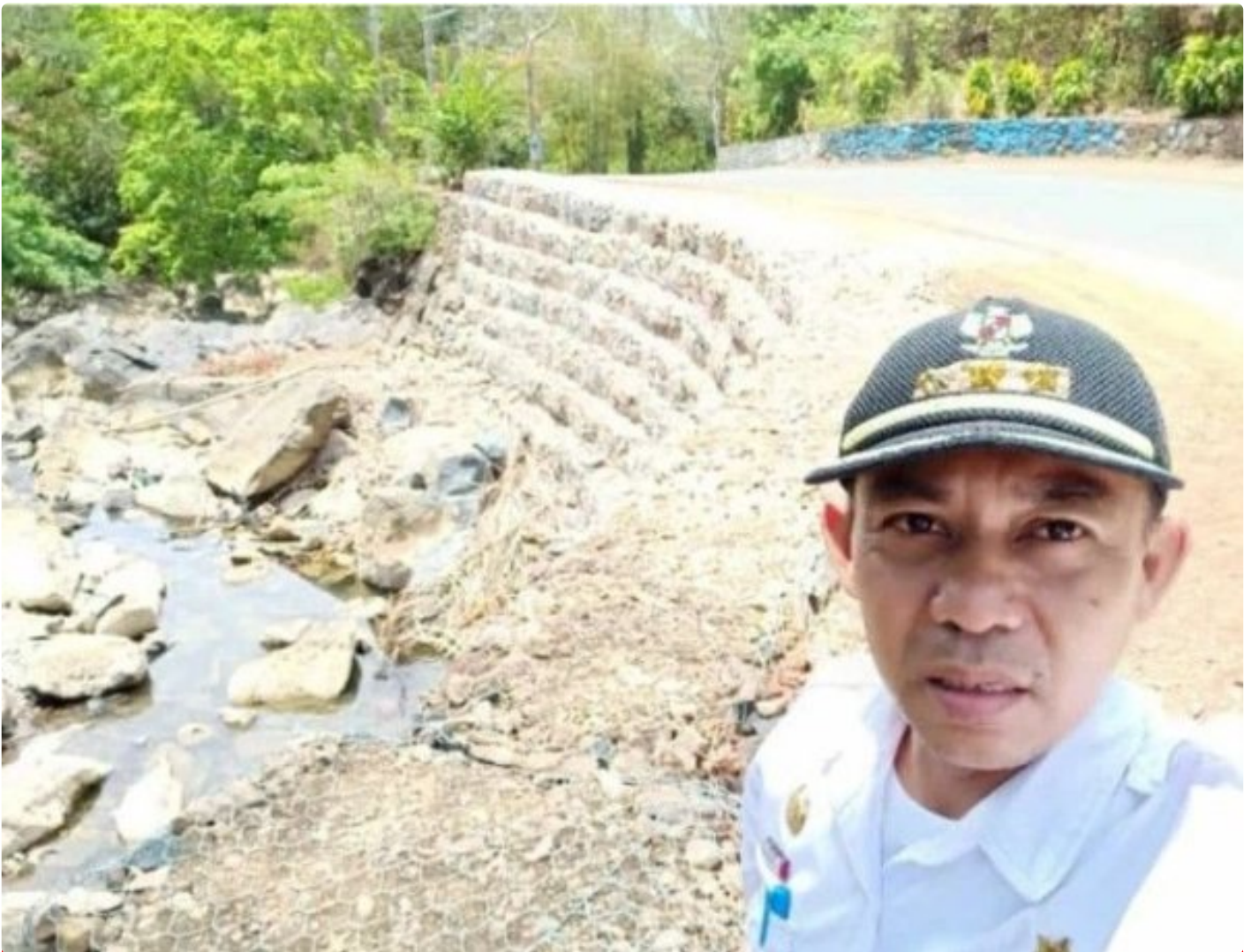
Camat Balocci M.Firmansyah Nur S,STp pantau pelaksanaan pemasangan Bronjong di sungai Sumpang Bita jalan poros Balocci
